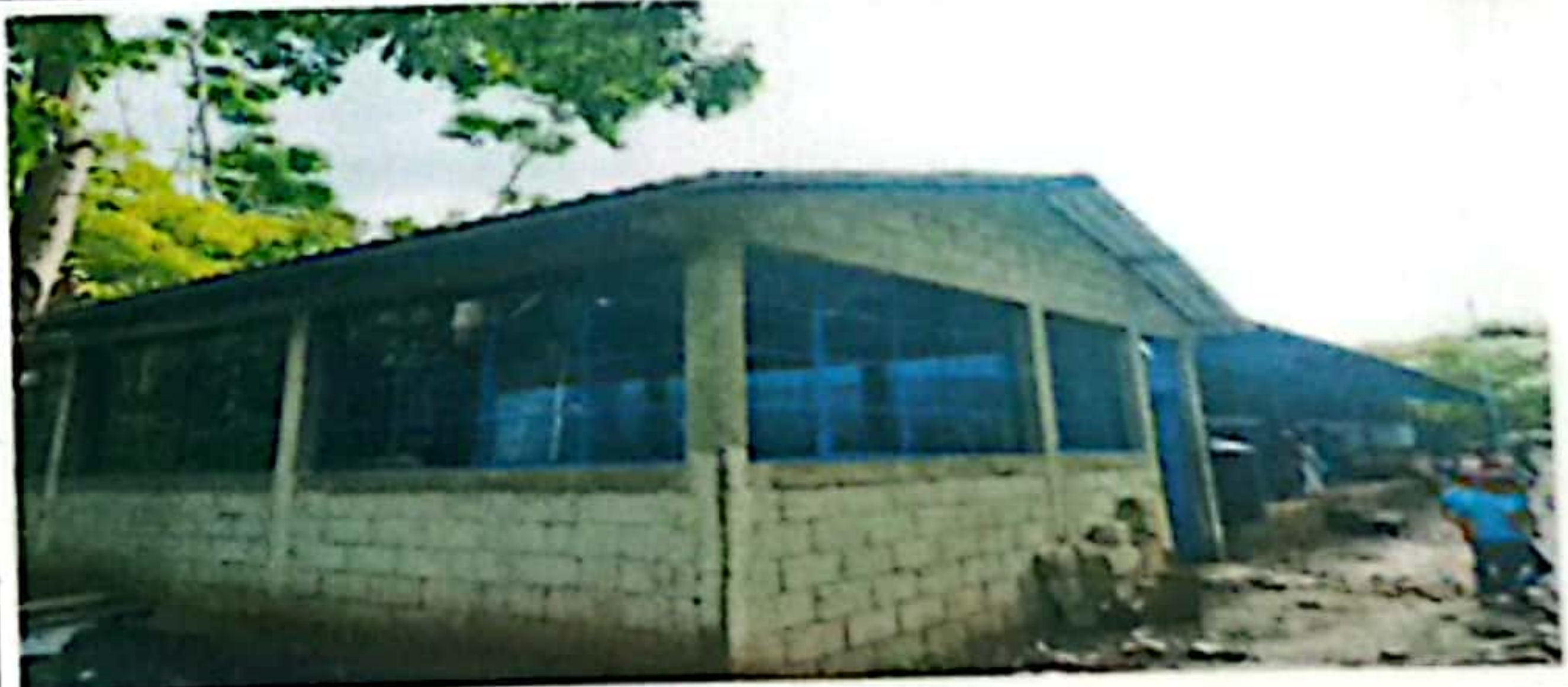
Foto 6: FINALIZACION DE INSTALACION VIDRIOS Y VENTANAS
