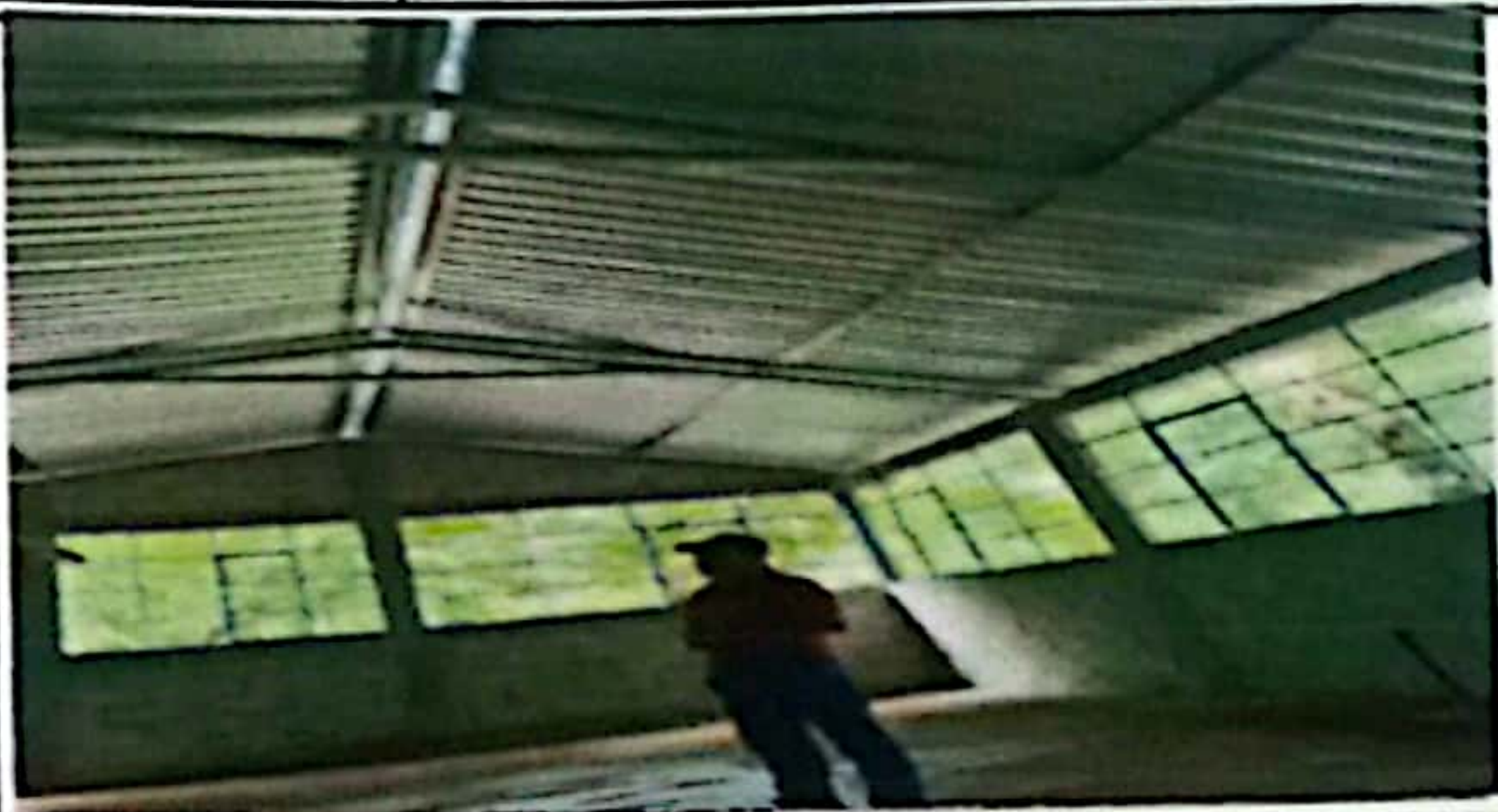
Foto1: FINALIZACION DE LA INSTALACION ESTRUCTURA DE TECHO
