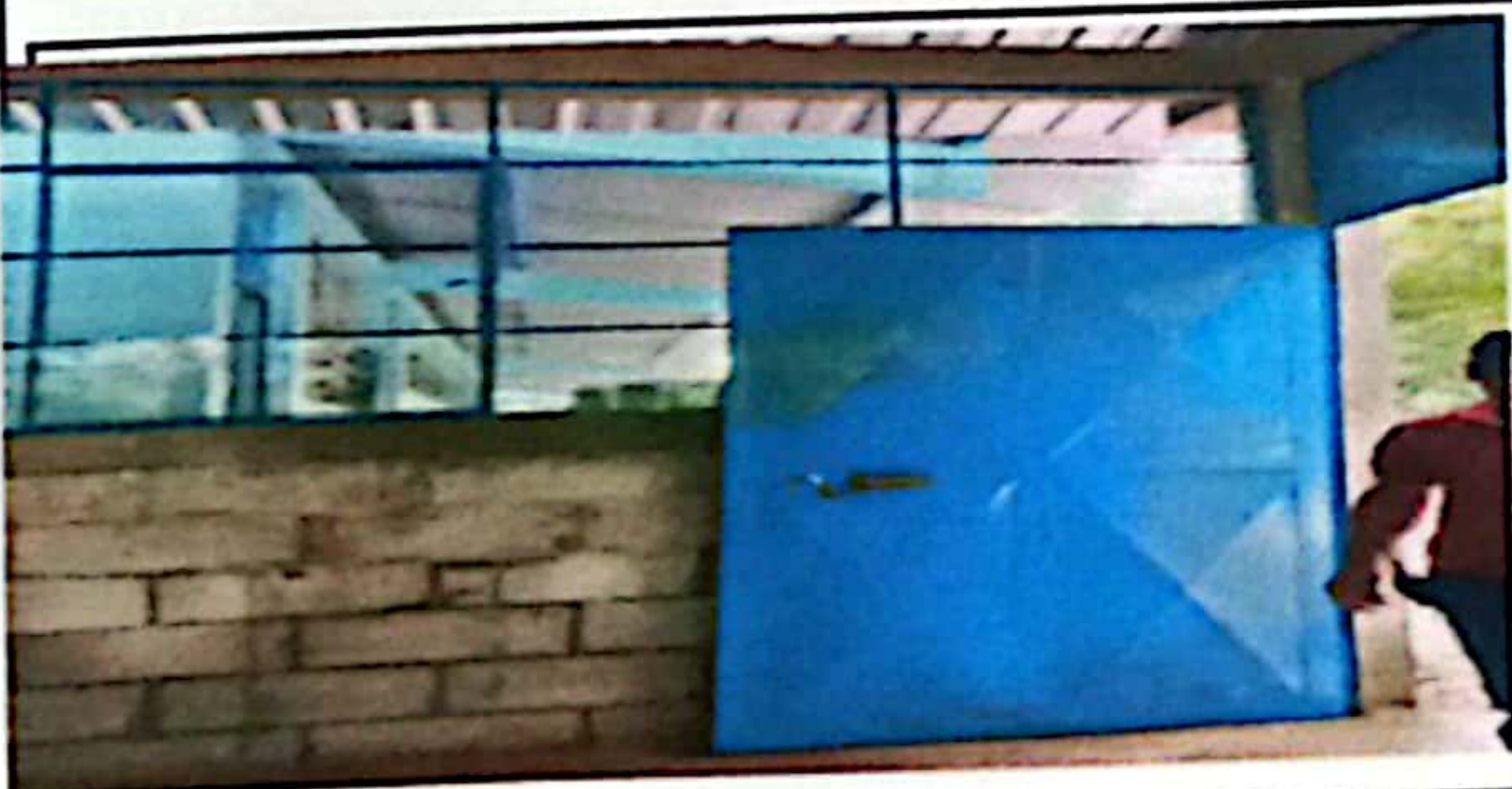
Foto 5: INSTALACION DE PUERTA
