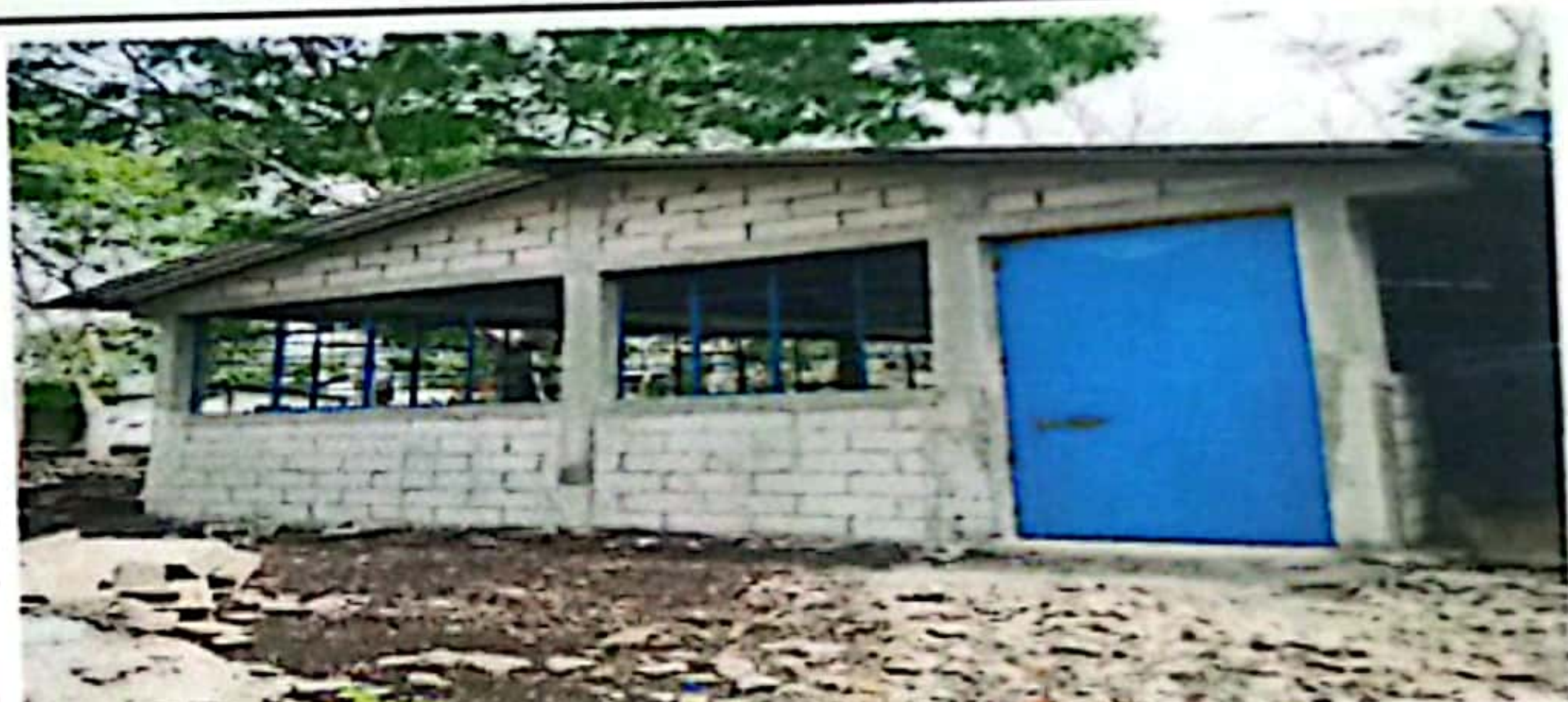
Foto 4: FINALIZACION MEJORAMIENTO DE PAREDES MODULO 1
