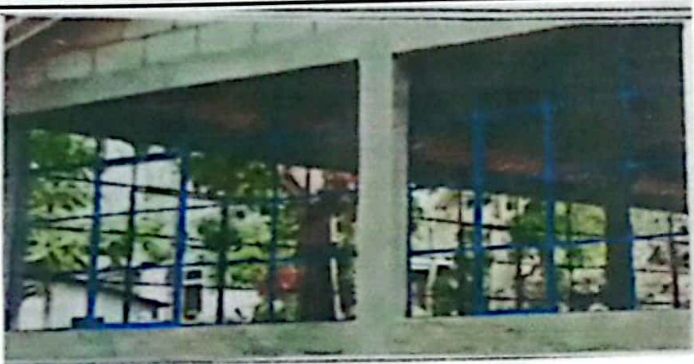
Foto 3: FINALIZACION DE INSTALACION DE VENTANAS
