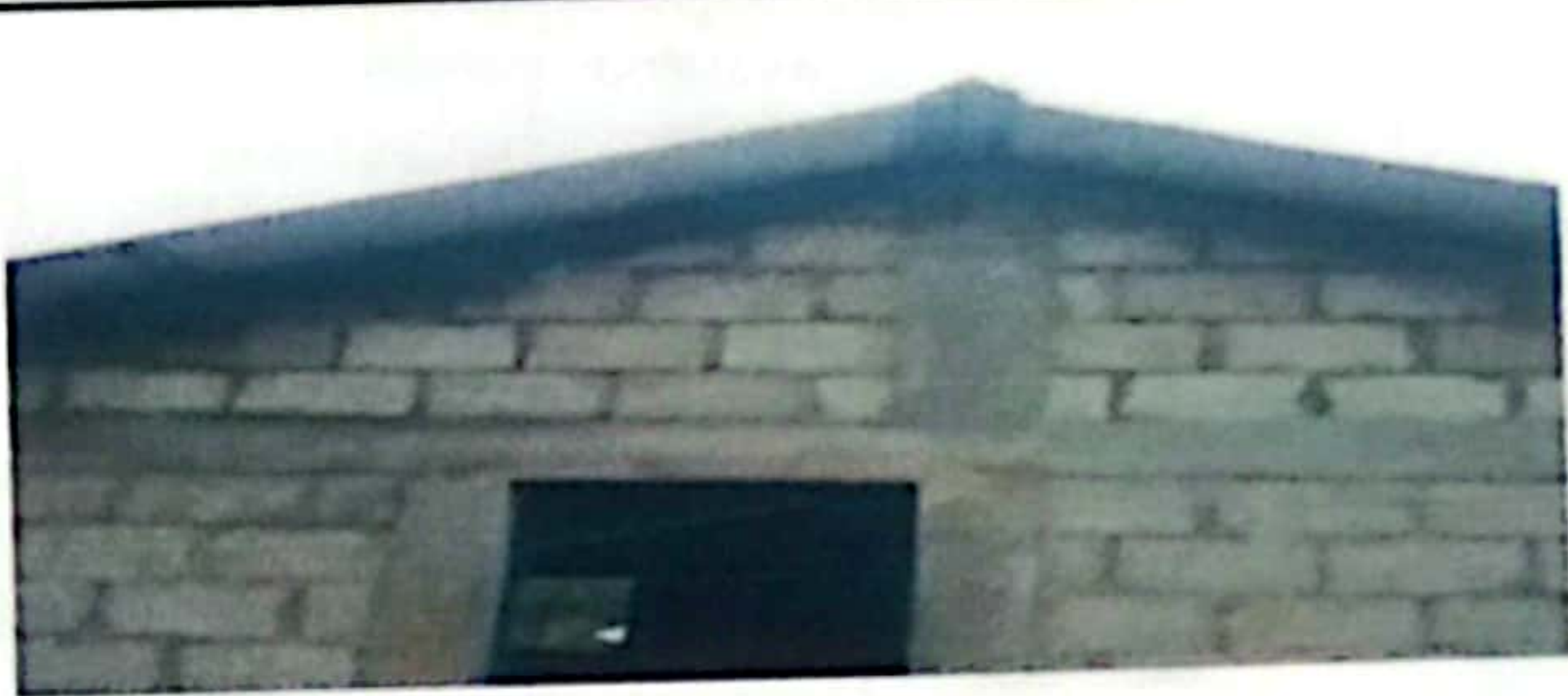
Foto 2: INSTALACION DE CUBIERTA DE LAMINA
